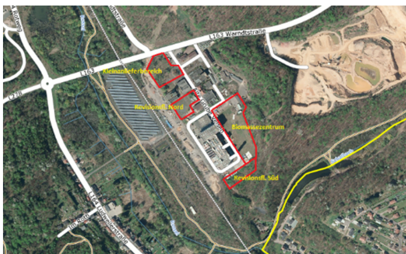
Fig 2 : Vue d'ensemble sur photo aérienne du site du projet AVA Velsen (esquissé en rouge)
