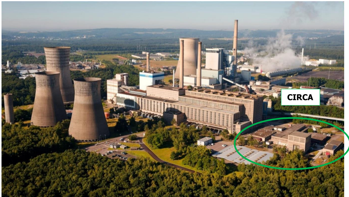
Figure 2 – Localisation du site CIRCA au sein de la centrale Émile Huchet
