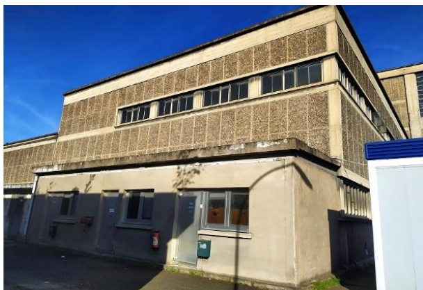
Photo 6 : Extérieur du bâtiment magasin-atelier
