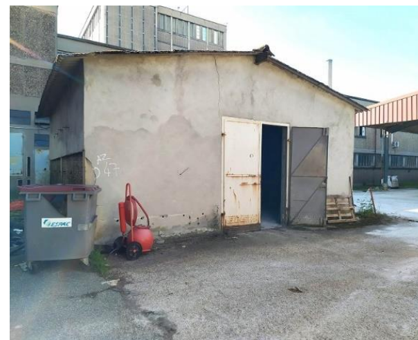
Photo 5 : Extérieur du bâtiment de stockage du tri sélectif 2 (est)
