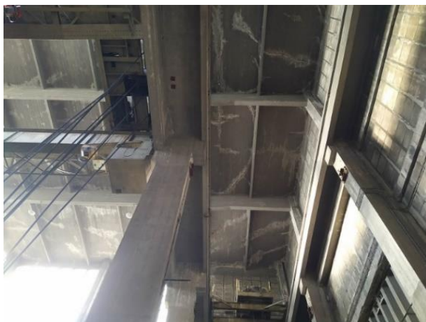
Photo 3 : Intérieur du bâtiment « halle de décuvage »
