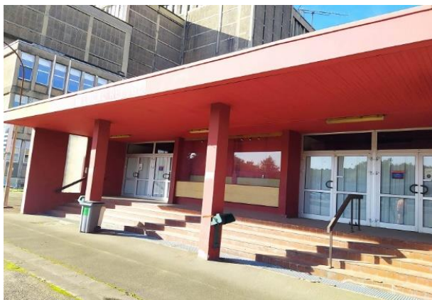
Photo 7 : Extérieur du bâtiment vestiaire-douche
