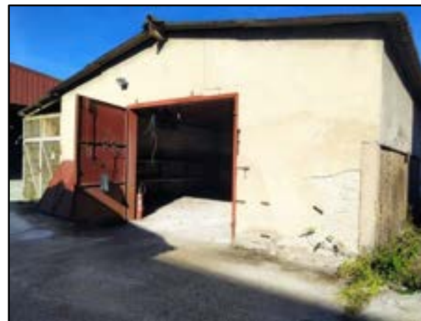
Photo 4 : Extérieur du bâtiment de stockage du tri sélectif 1 (ouest) (Rainette 2020).
