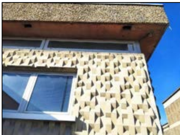
Photo 11 : Ouvertures sous le toit du bâtiment vestiaire-douche
