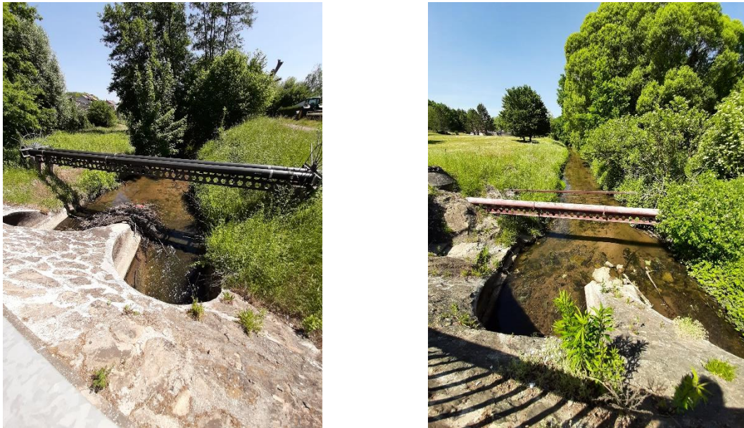
Figure 47 : Etat de la Bisten en amont de la station communale
