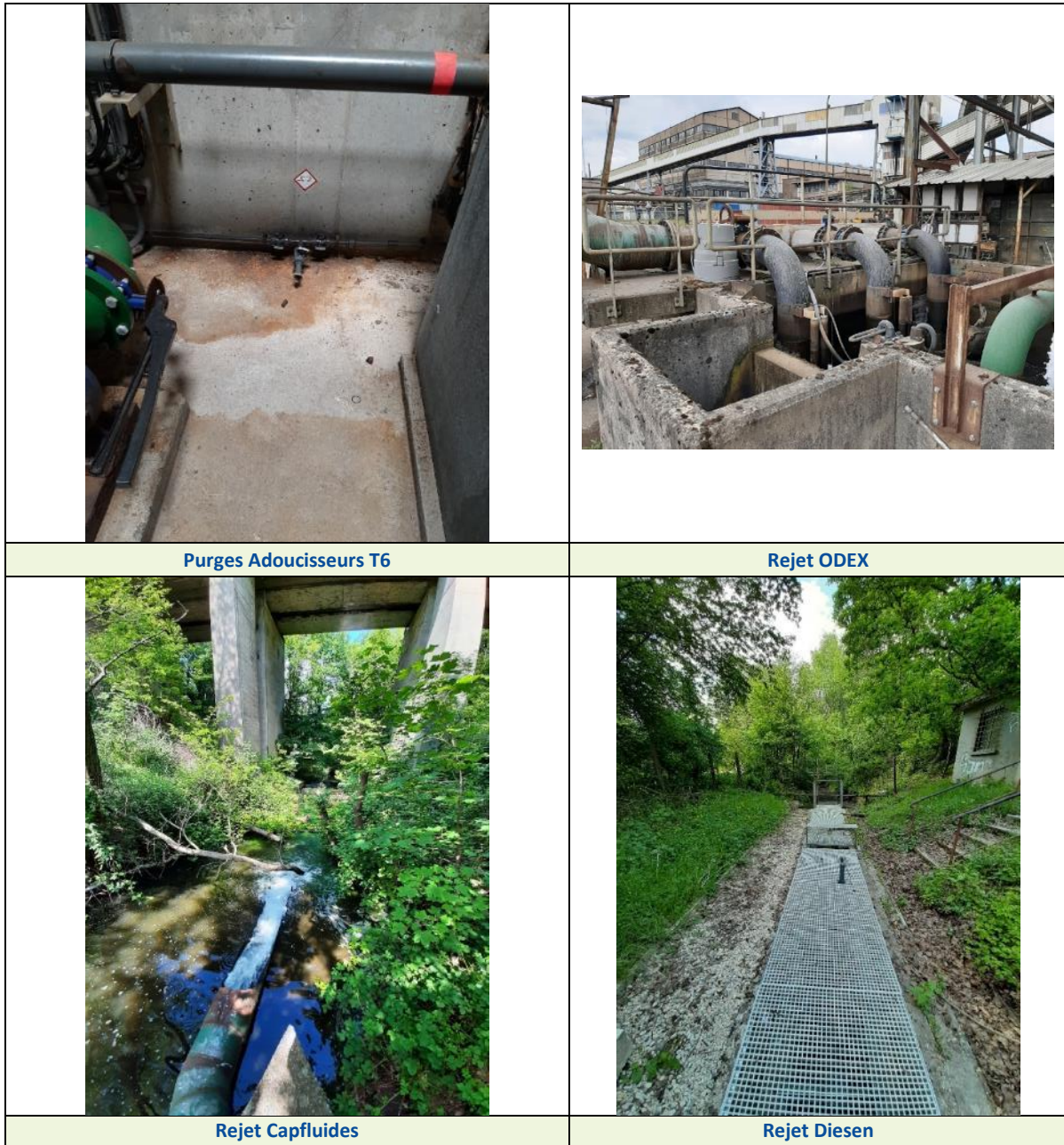
Figure 38 : Photographies des points de mesures Gazel Energie
