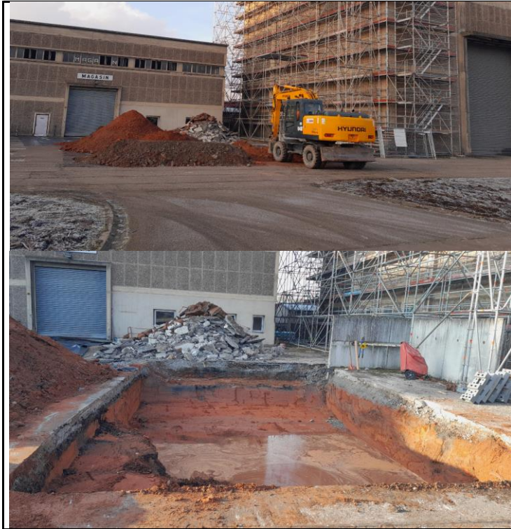
Démolition et terrassement SC9
