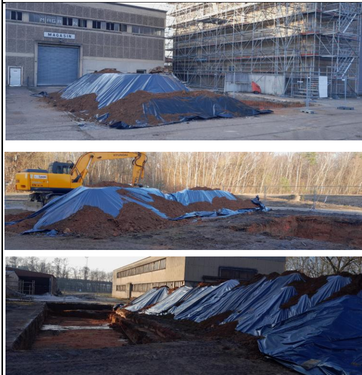
Sécurisation du site et bâchage des tas de terre
