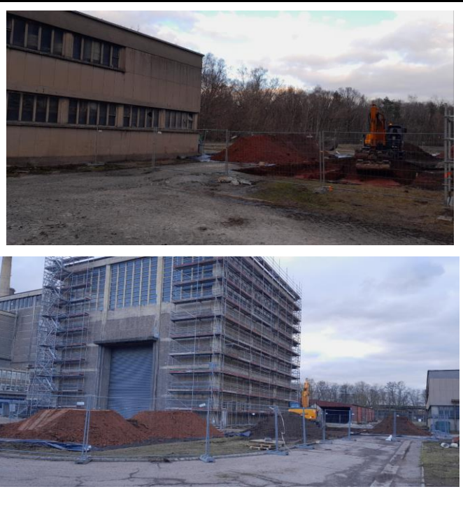
Sécurisation du chantier
