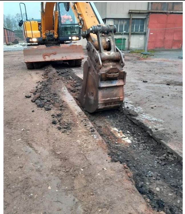
Terrassement SC2 B5
