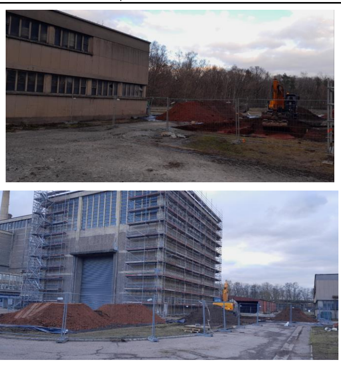
Sécurisation du chantier
