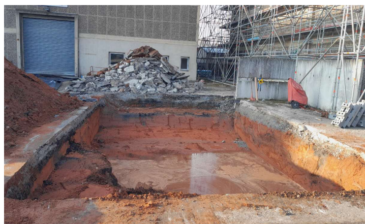
Terrassement de la zone SC9
