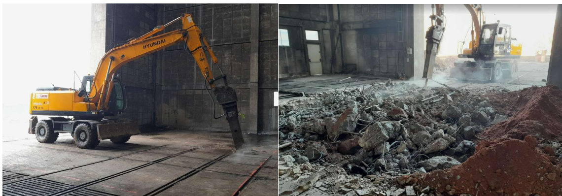
Retrait des revêtements béton et rails au droit de la zone S83
