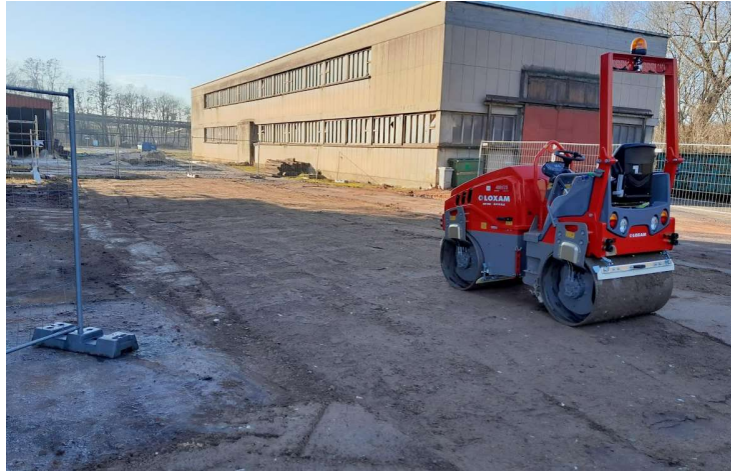
Remblaiement et compactage des fouilles
