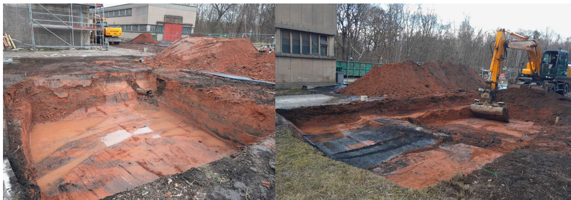
Terrassement de la zone SC7 (à gauche) et de la zone SC2 S7/S8 (à droite)
