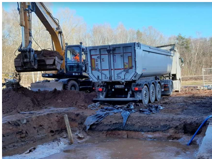
Chargement et évacuation des terres polluées
