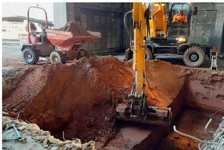
Terrassement de la zone S83 jusqu'à 2m de profondeur
