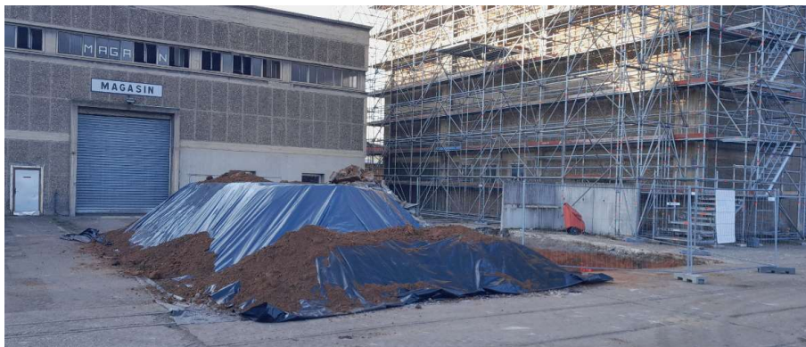
Stockage des terres avant évacuation
