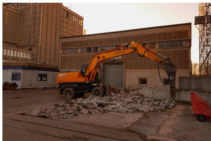
Démantèlement des revêtements béton au droit de la zone SC9
