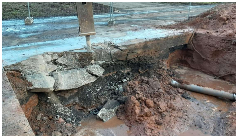
Terrassement supplémentaire SC9
