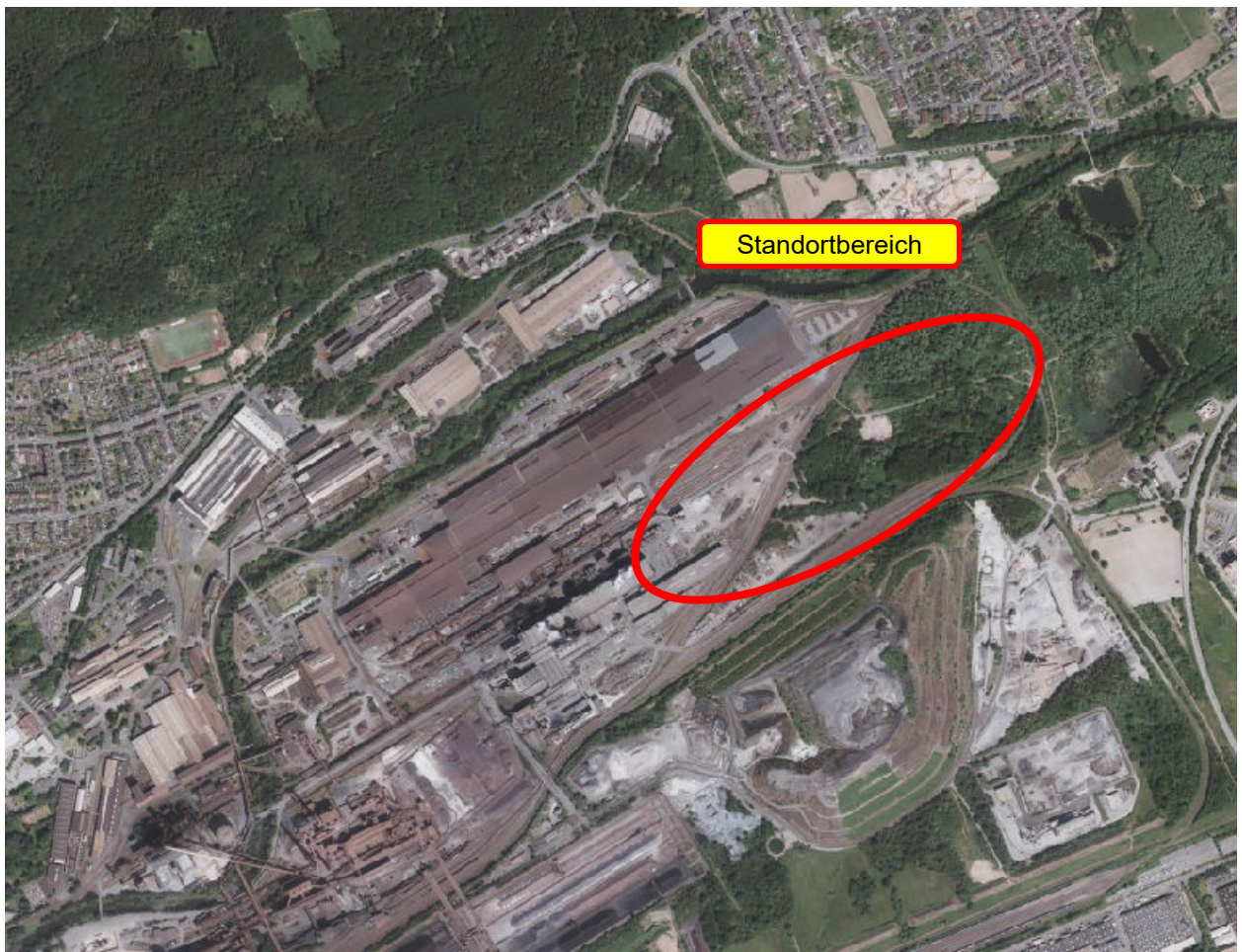
Abbildung 2 Luftbild: Vorgesehener Aufstellbereich (Quelle: www.geoportal.saarland.de )
