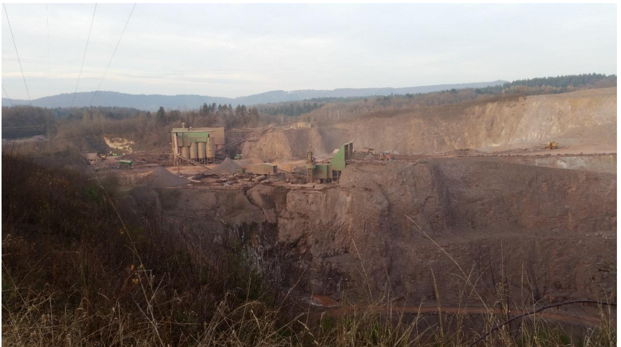
Abb. 1: Blick vom Südwestrand auf das Hartsteinwerk in Beckingen-Reimsbach.
