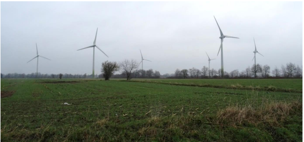
Abb. 16: Das flache Relief und die durchschnittliche Strukturvielfalt ermöglichen eine weite Sicht auf den bestehenden Windpark
