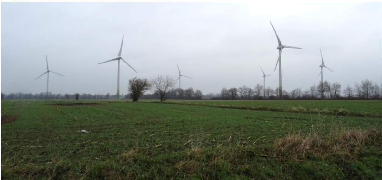
Abb. 13: Das flache Relief und die durchschnittliche Strukturvielfalt ermöglichen eine weite Sicht auf den bestehenden Windpark
