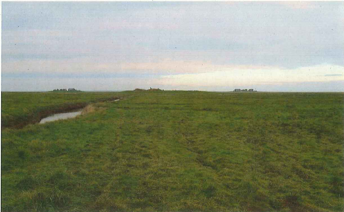
Bereich des geplanten Verlaufs der südlichen Spülleitung zwischen Steinkante und der Warftreuber (in der Bildmitte)
