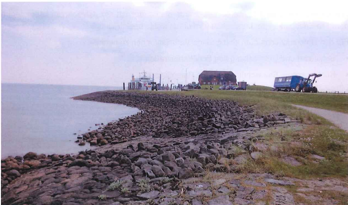
Abbildung 19: Sommerdeich, Steinschüttungen entlang des Halligkante (S) und im Hintergrund Hafennutzung (H) sowie Warften, Siedlungsflächen (SD) (Eigenes Foto vom 23.05.2017)
