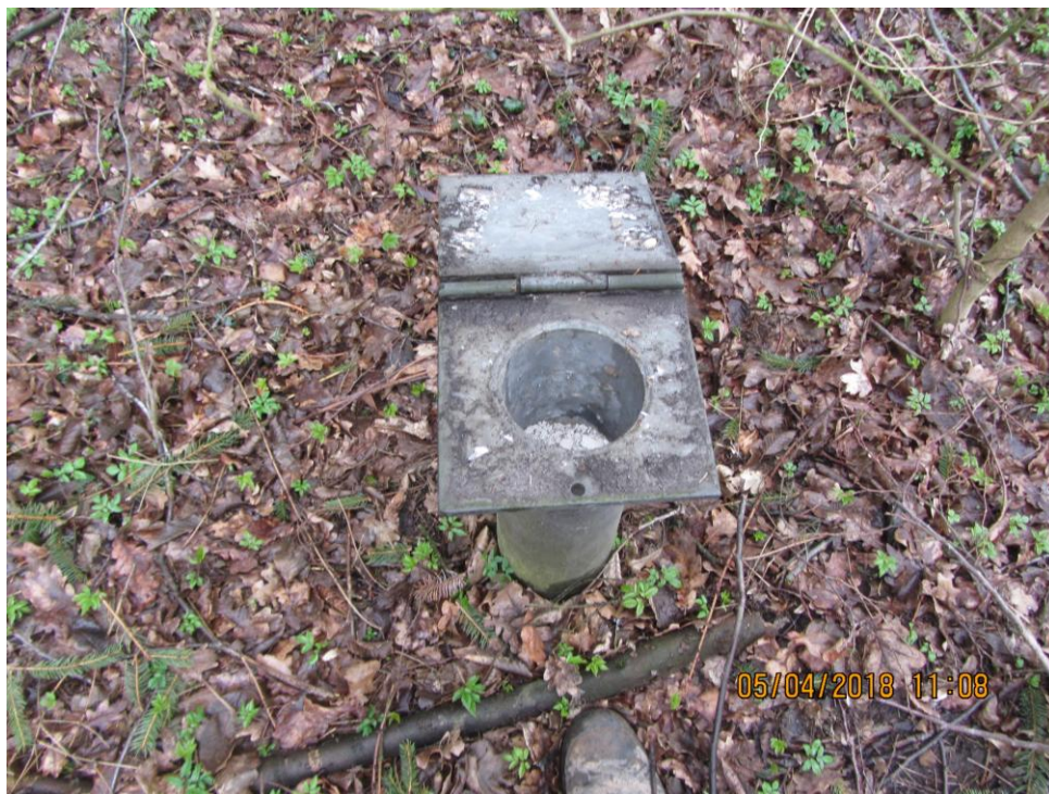
Abbildung 3: Verfüllte Grundwassermessstelle 1406-B0004a
