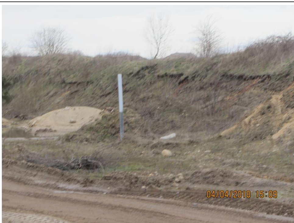
Abbildung 4: Abgerutschtes Schutzrohr an GWM 1406-B0059a
