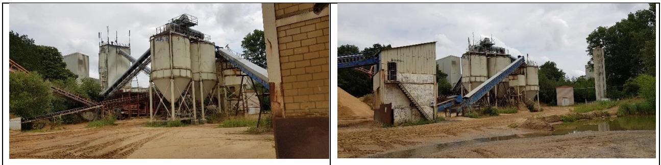
Abbildung 7: Siloanlage mit Transportbändern
