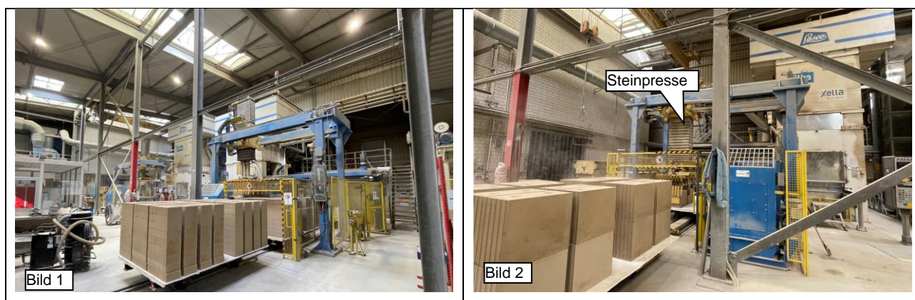
Abbildung 9: Aufstellungsorte der Steinpressen in der Produktionshalle
