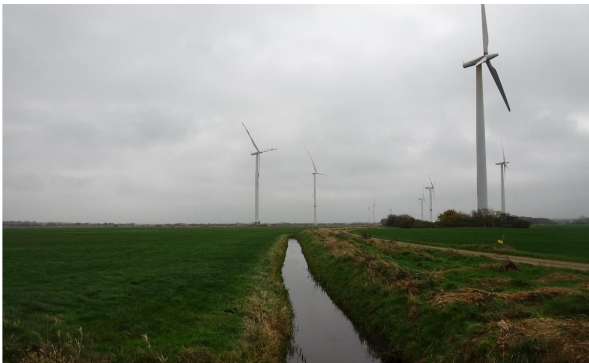
Fig. 8: Set fra en grøft og tilstødende tilkørselsvej som bygget til højre i BR med udsigt til anlæg der skal fjernes og eksisterende anlæg.
