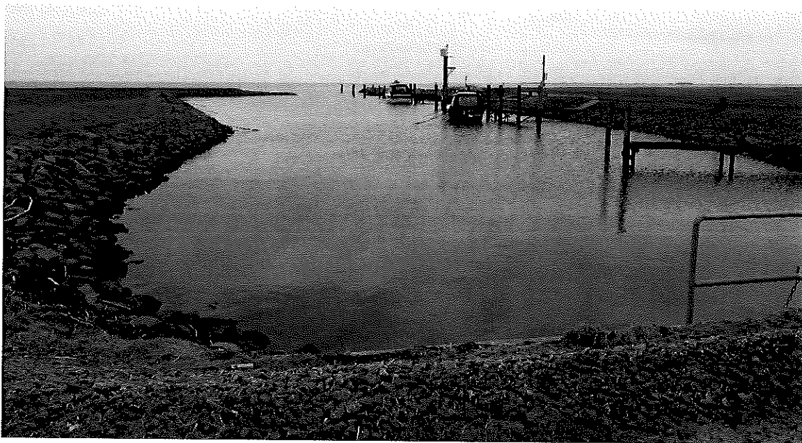
Abbildung 19: Hafenanlage (SKh) südlich der Norderwarf
