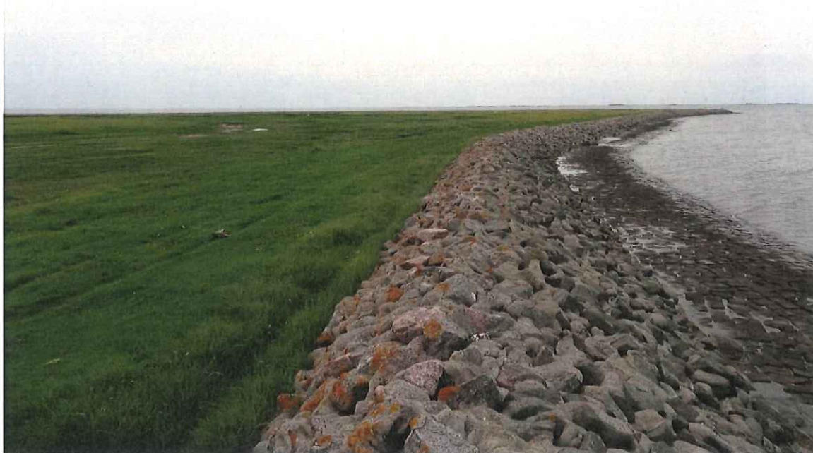
Abbildung 17: Ufersicherung der Hallig aus Setzsteindeckwerk (SKv) und Mastixschotter (SKm)
