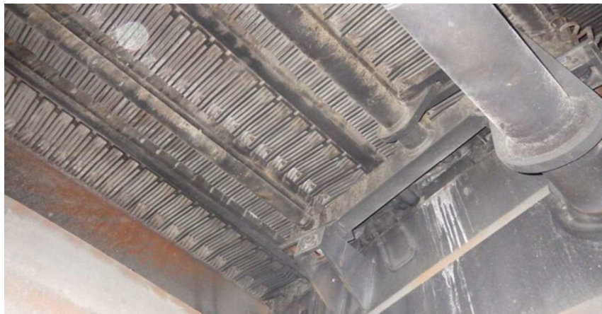
Abbildung 4 Blick von unten auf den Rost (Quelle: SBEng)
