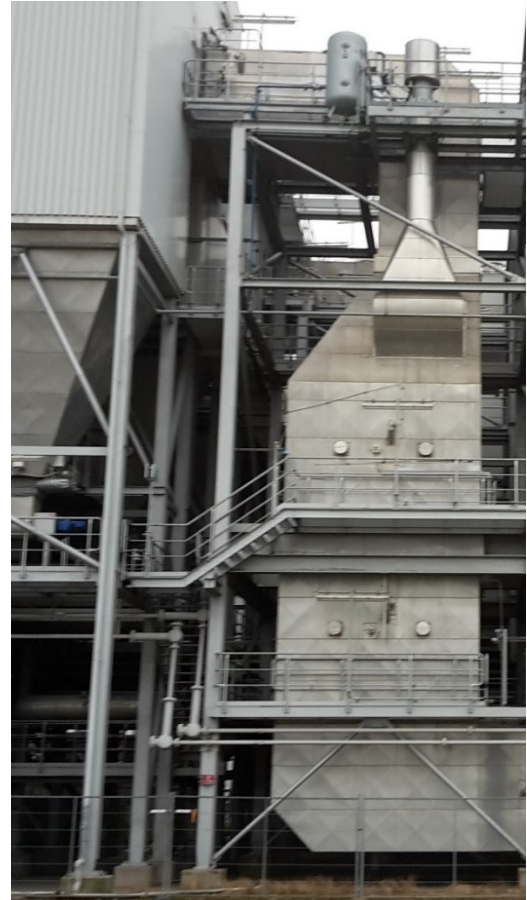
Abbildung 7 Beispielhafte Darstellung eines SCR-Reaktors (Quelle: LÜHR FILTER GmbH & Co KG, u&i GmbH)
