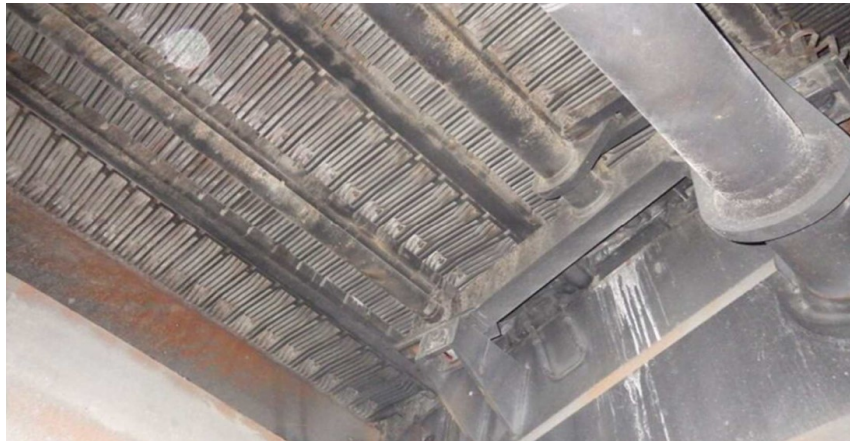
Abbildung 9 Blick von unten auf den Rost (Quelle: SBEng)
