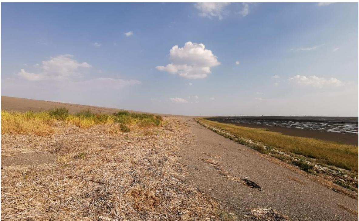
Abbildung 4 **Asphaltdeich mit Treibselablagerungen und schmalem Vorland**
