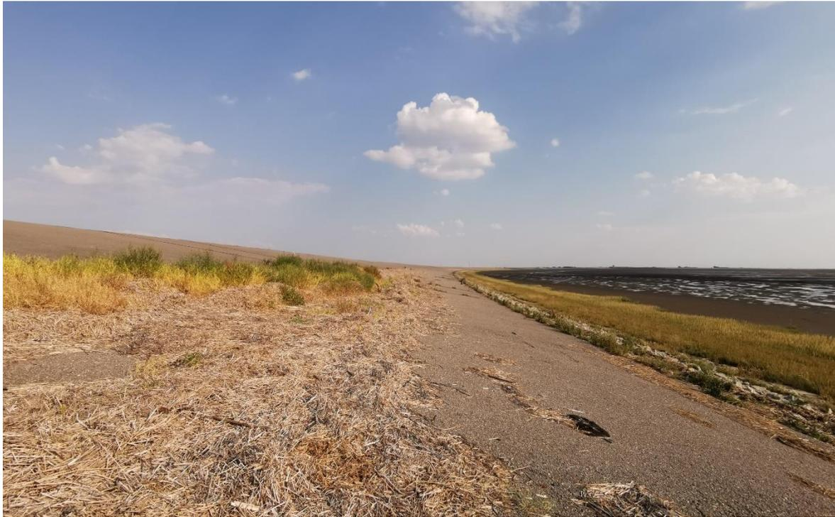
Abbildung 5 **Asphaltdeich mit Treibselablagerungen und schmalem Vorland**
