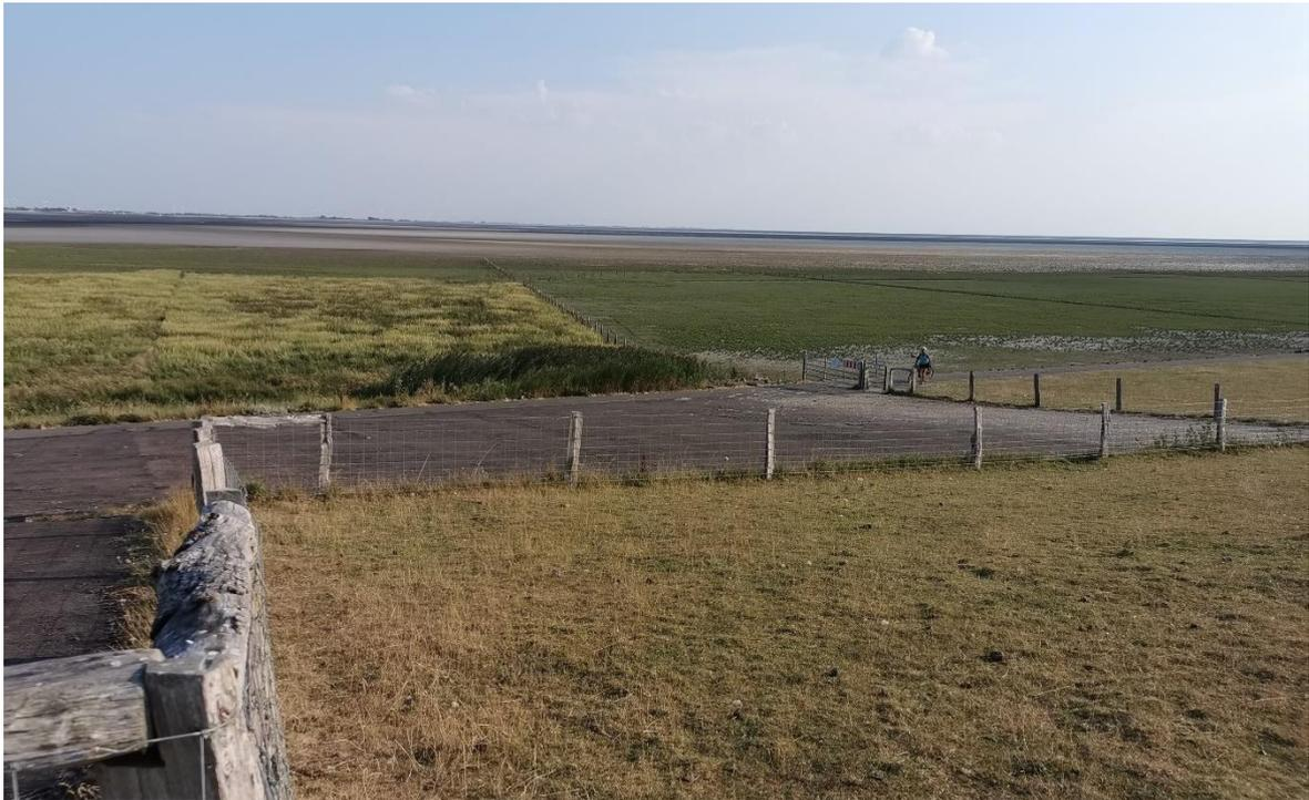
Abbildung 7 Nordwestlicher Übergang des Asphaltdeiches in einen Gründeich, Vorland mit Lahnungen
