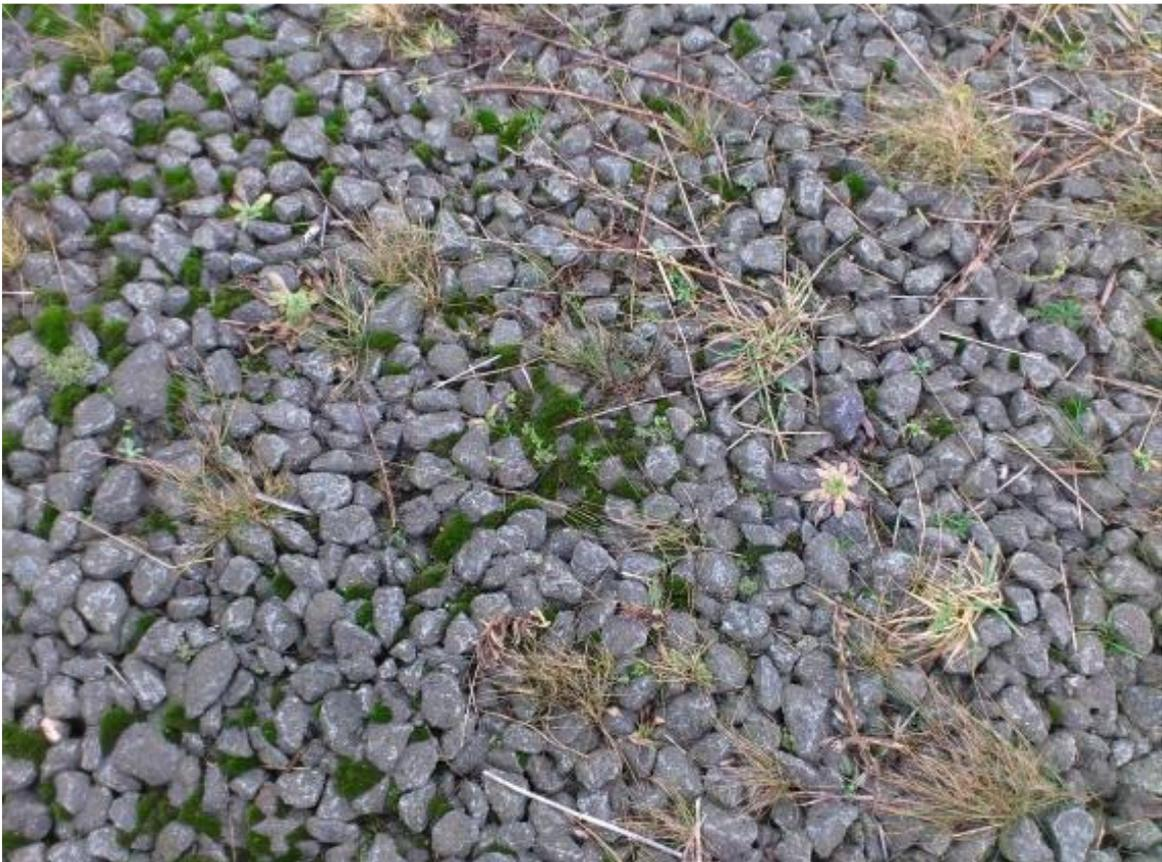
Abbildung 20 Asphalt- / Mastixschotter
