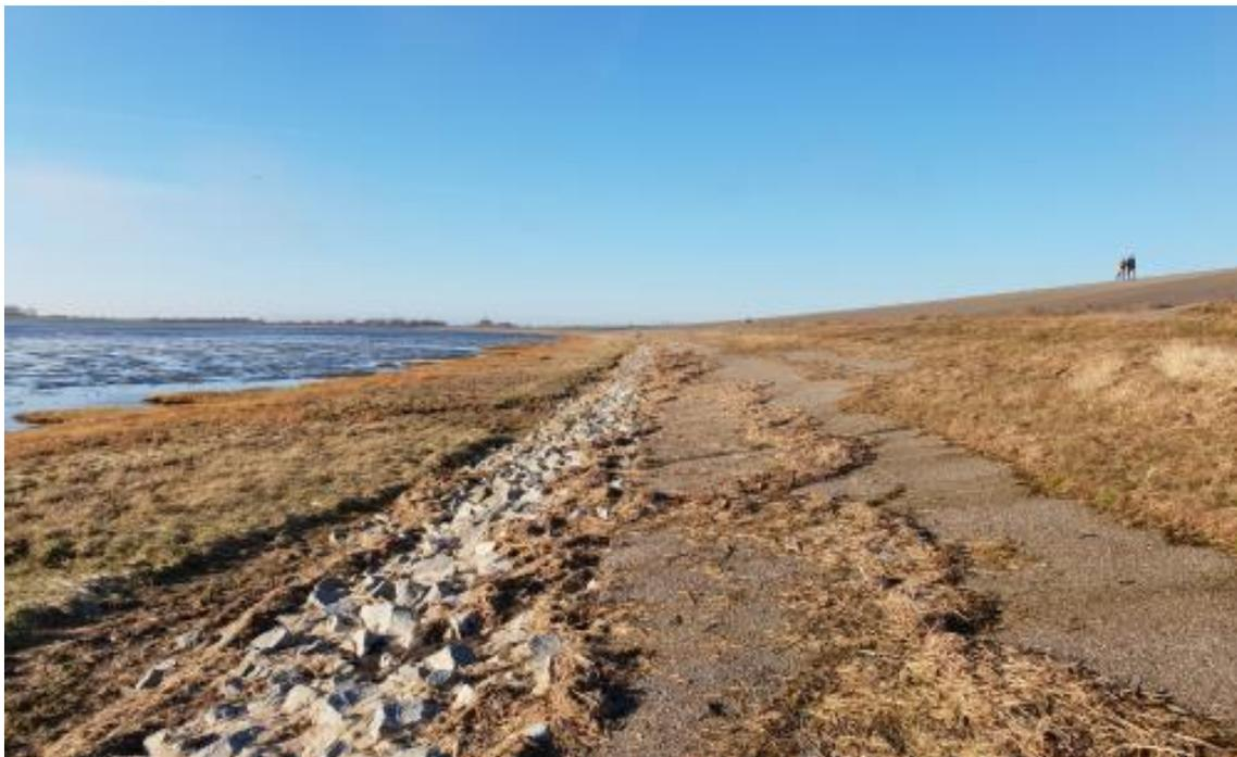
Abbildung 4 **Deichfuß mit Treibsel auf dem Asphaltdeich, vollverklammerte Steinschüttung und Salzwiesensaum unterhalb des Deiches**
