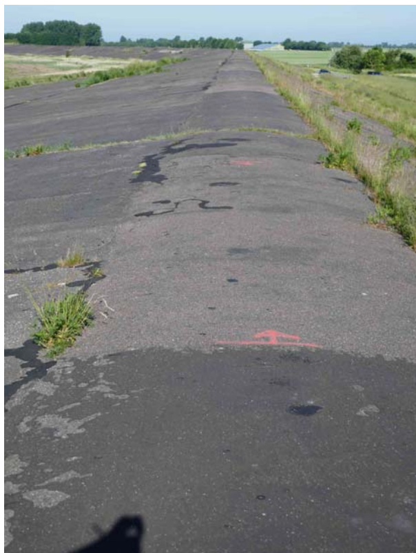
Abbildung 4: Entnahmestelle 2 (Bild HNL)
