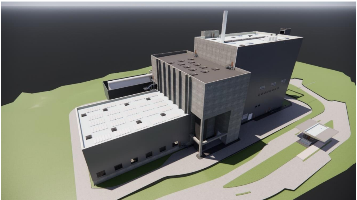
Abbildung 2.7 Anlagenaufstellung (Blick aus nordöstlicher Richtung)
