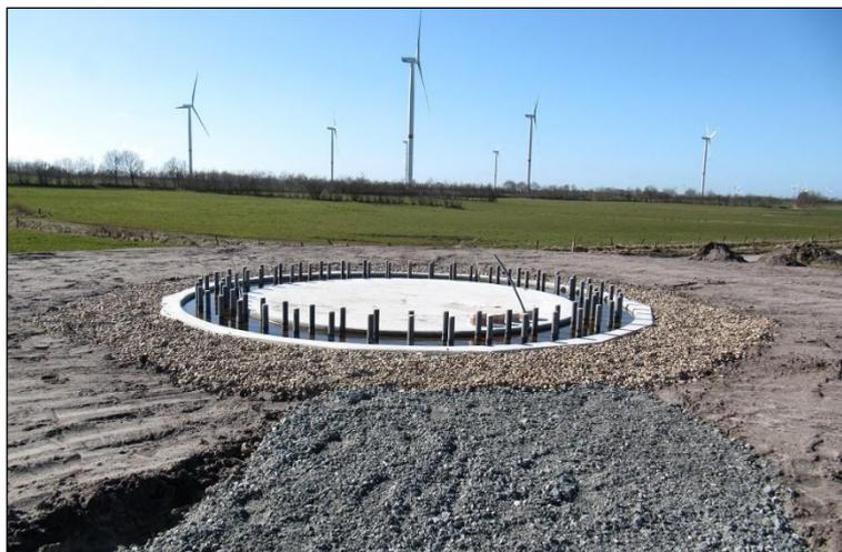
Abb. 1.3.5: Episodisch ausgelegte Bodenplatten für Montagearbeiten am Kran
