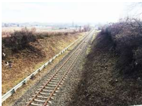
Blick von der nördlich gelegenen Brücke nach Süden; im Bildhintergrund ist die Bahnüberquerung der L 522 zu sehen
