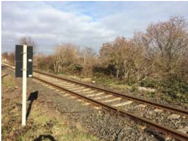
Blick über die Bahngleise auf die östlich daran angrenzende Böschungshecke; zwischen Bahngleisen und Hecke ein offen liegender Kabelkanal
