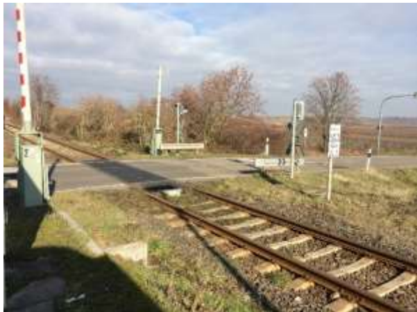
Blick Haltepunkt Herxheim am Berg über die L 522 nach Nordost auf die Heckstruktur im geplanten Eingriffsbereich
