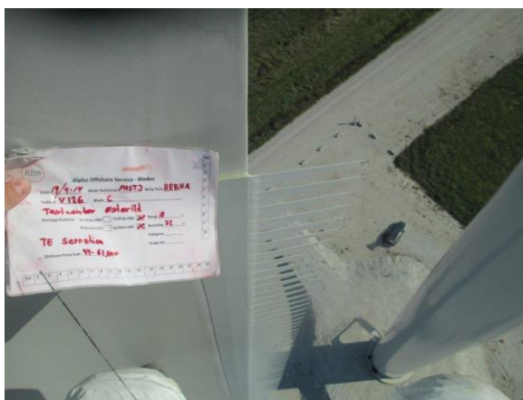
Bild 3: Sägezähne nach der Montage an einem Blatt oben am Turm
