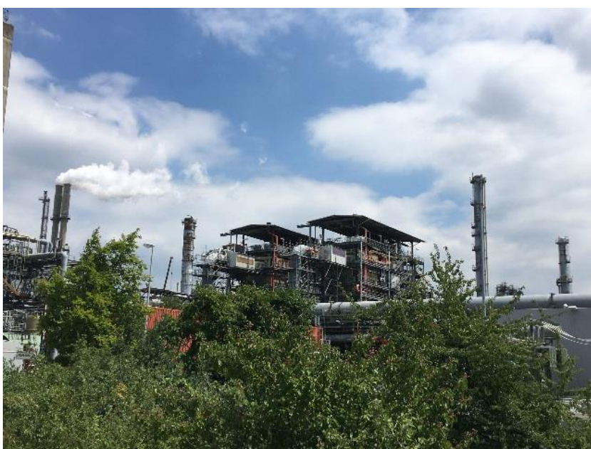
Foto 1: Blick von Westen (Tor) auf die bestehende Rückstandsverbrennungsanlage
