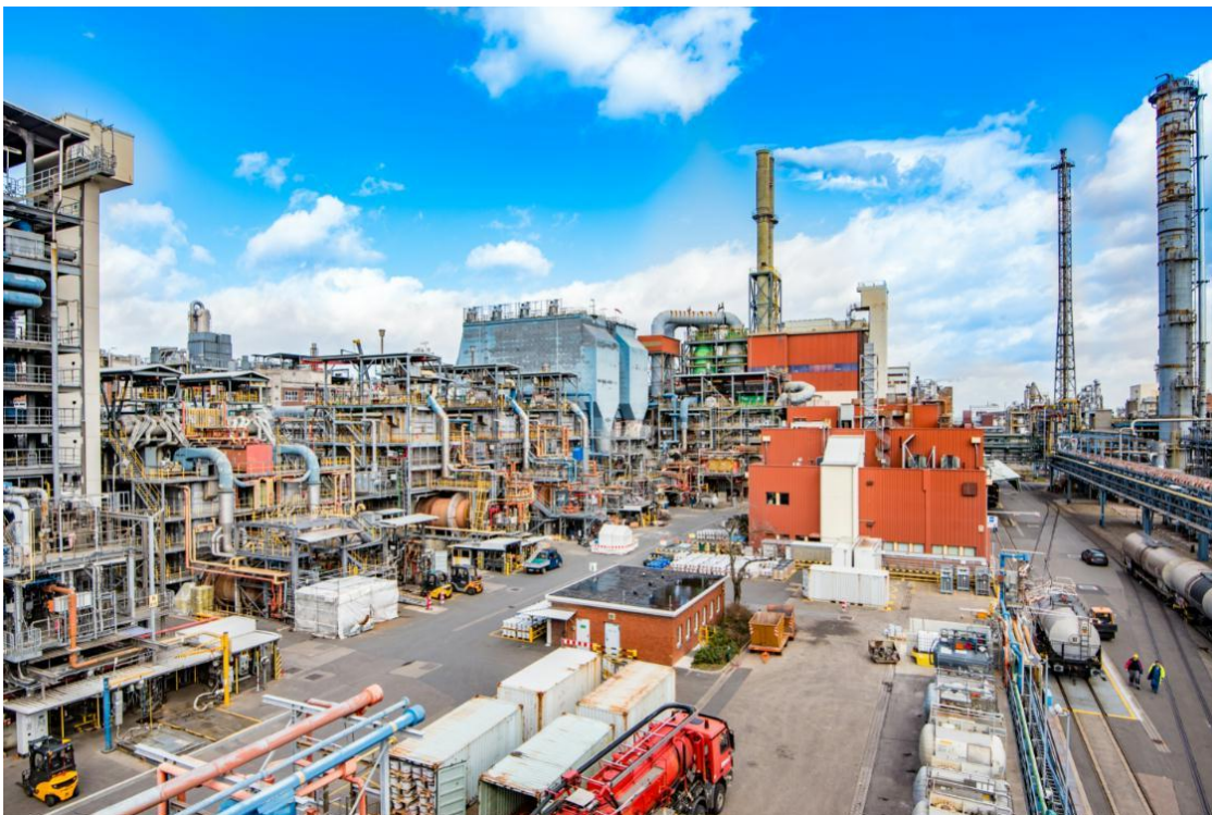
Foto 2.2-2: Blick auf die bestehende Rückstandsverbrennungsanlage - Überblick Quelle: BASF SE, 2018
