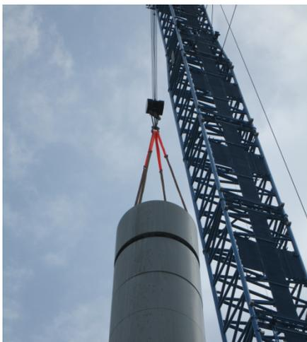
**Abb. 11: Angeschlagenes Betonsegment**
