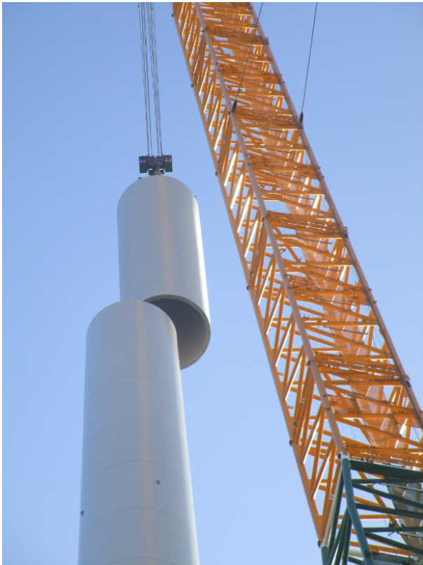
Abb. 4: Montage einer Stahlsektion
