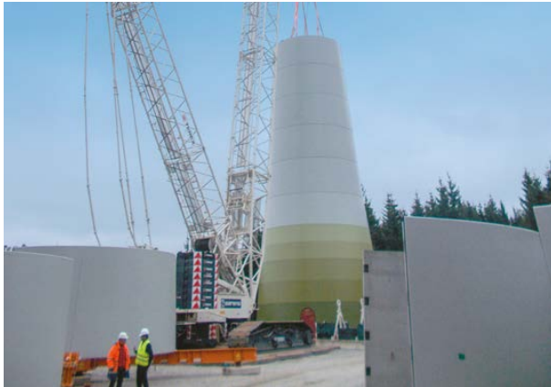
Abb. 3: Montage des Hybridturms
