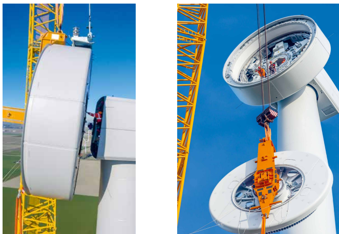
Abb. 8: Montage des Generator-Stators (links) und Generator-Rotors (rechts)
