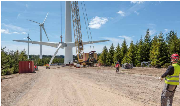
Abb. 9: Montage des Rotorkopfs mit 3 montierten Rotorblättern (Sternmontage)
