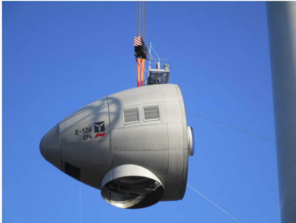
Abb. 7: Montage des Maschinenhauses
