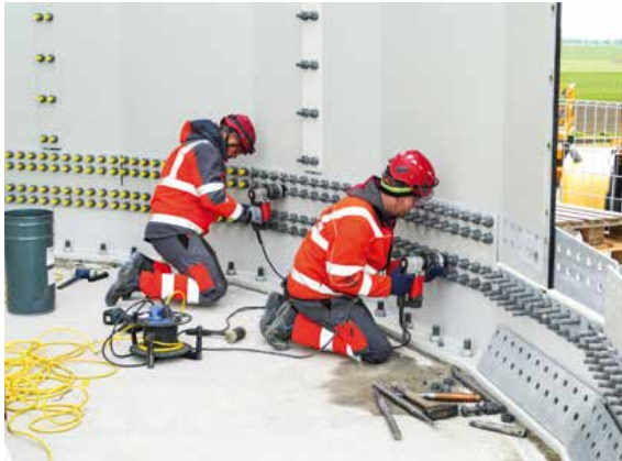
Abb. 5: Montage der untersten Sektion des MST
