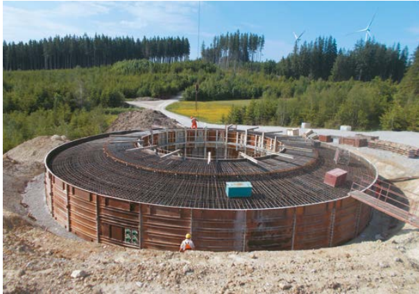
Abb. 1: Schalung und Bewehrung des Fundaments beim Hybridturm
