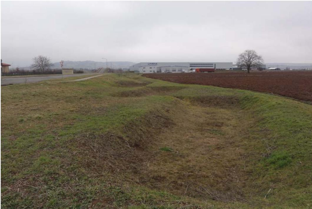
Abbildung 36: Versickerungsanlage im Gewerbepark
