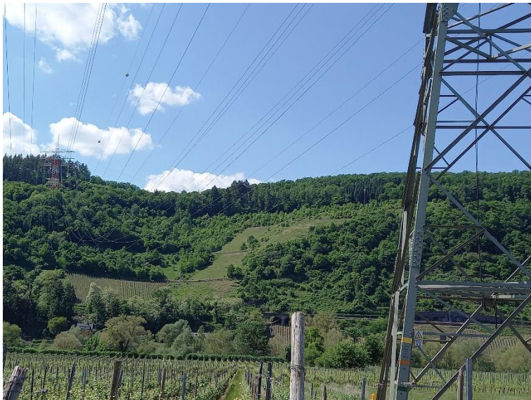
Abbildung 29: Blick von der UA Pünderich auf Mast 13 sowie den Moselhang mit Mast 12, Blickrichtung Westen.
