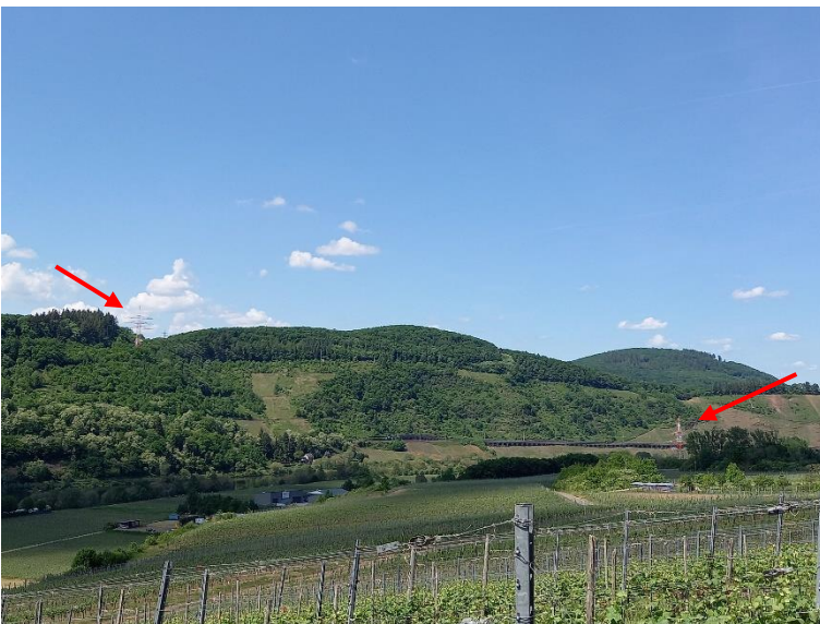
Abbildung 28: Blick über die Moselterrasse bei Pünderich, links im Bild Mast 12 und rechts im Bild Mast 13 zu sehen, Blickrichtung Nordwesten.
