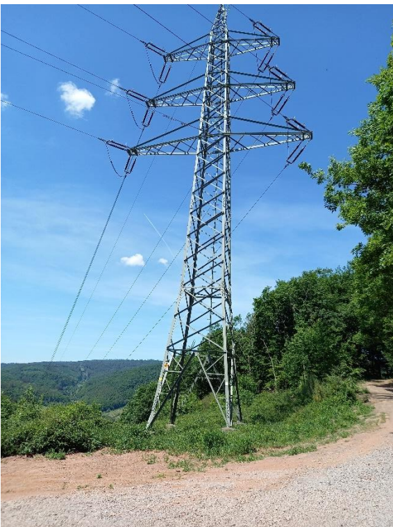
Abbildung 20: Mast 11, Blickrichtung Nordwesten.
