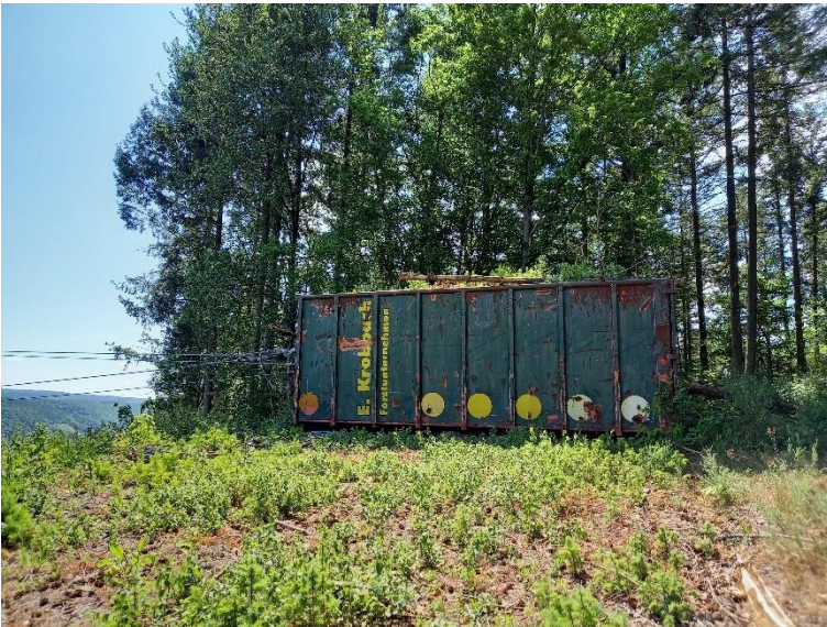
Abbildung 23: Container auf dem Höhenrücken, die aktuell Mast 12 zur Stabilisierung mit Stahlseilen halten, Blickrichtung Süden.
