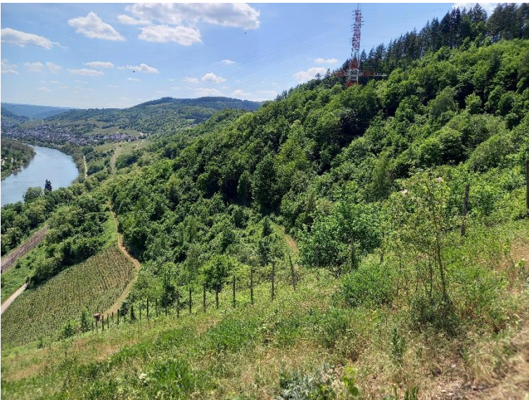
Abbildung 24: Moselhang im Umfeld von Mast 12, Blickrichtung Süden.
