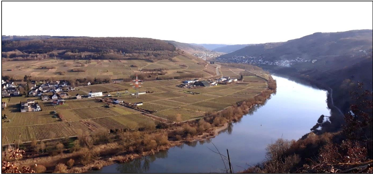
Abbildung 4: Blick vom Moselhöhenrücken in Richtung Süden auf Mast 13, links im Bild beginnt die Ortslage von Pünderich.
