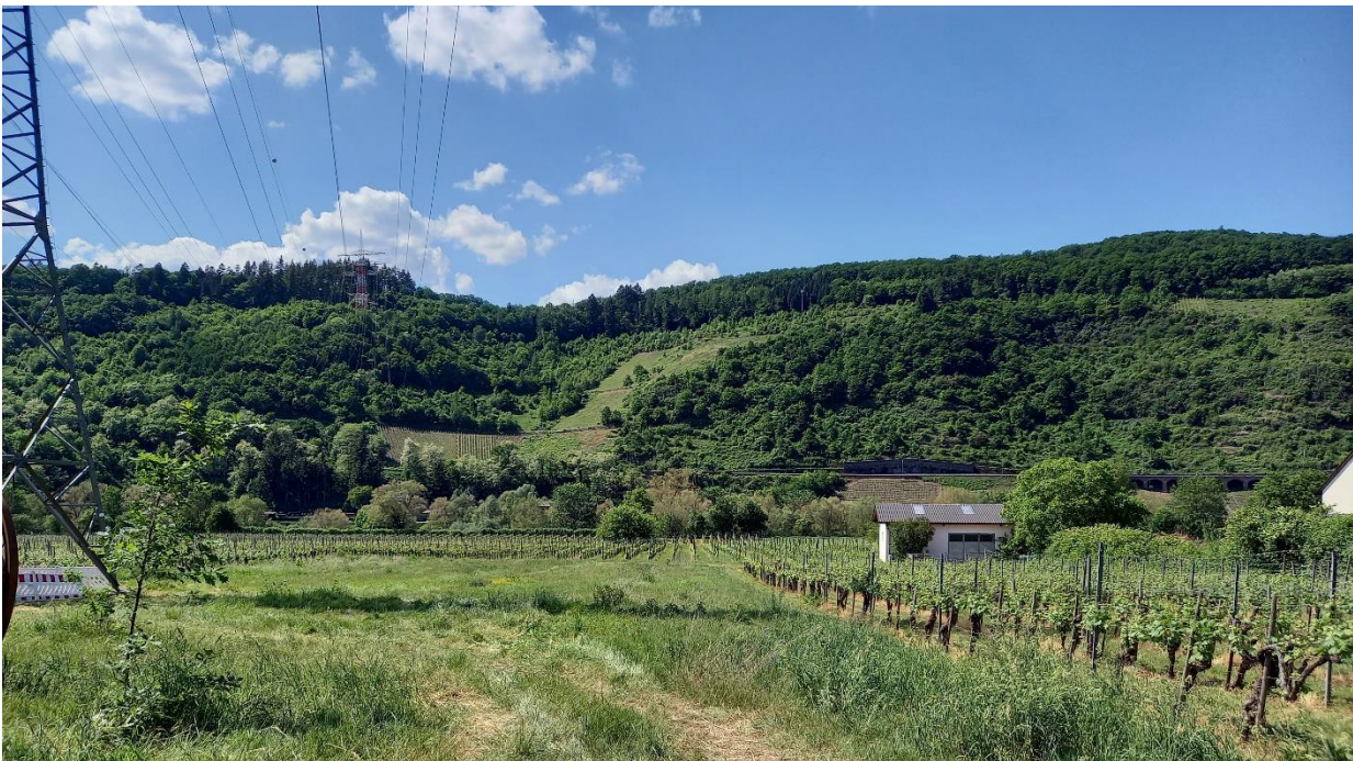
Abbildung 10: Sicht auf die bestehende Leitung BI. 1024 von der UA Pünderich aus.
