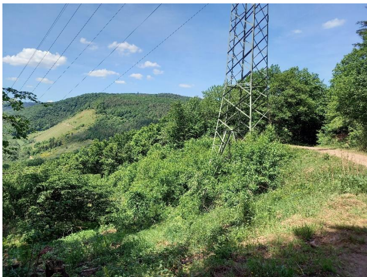
Abbildung 17: Mast 10, Blickrichtung Nordwesten.
