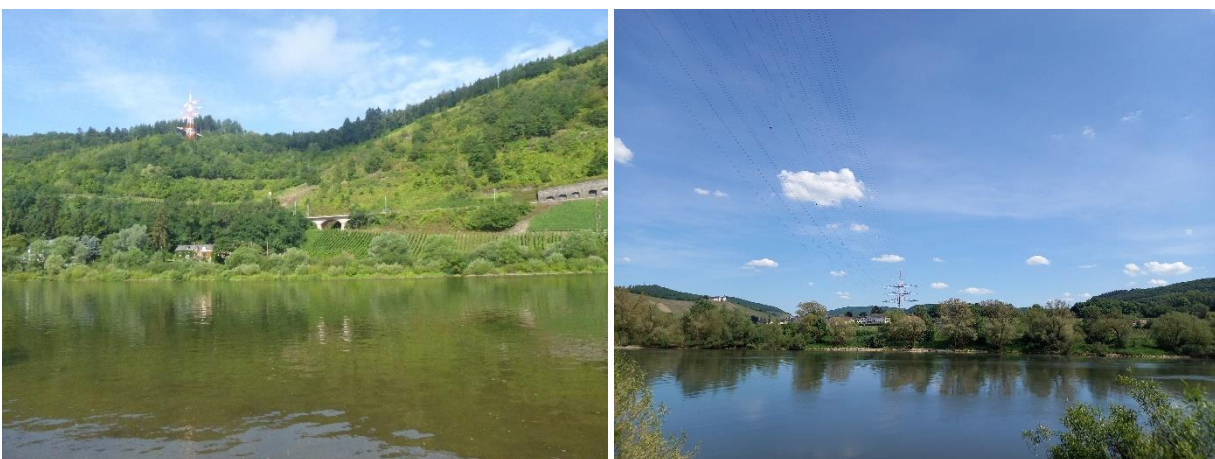
Abbildung 3: Blick vom östlichen Moselufer nach Westen auf Mast 12 (Foto links) sowie vom westlichen Moselufer nach Osten auf Mast 13 (Foto rechts).
