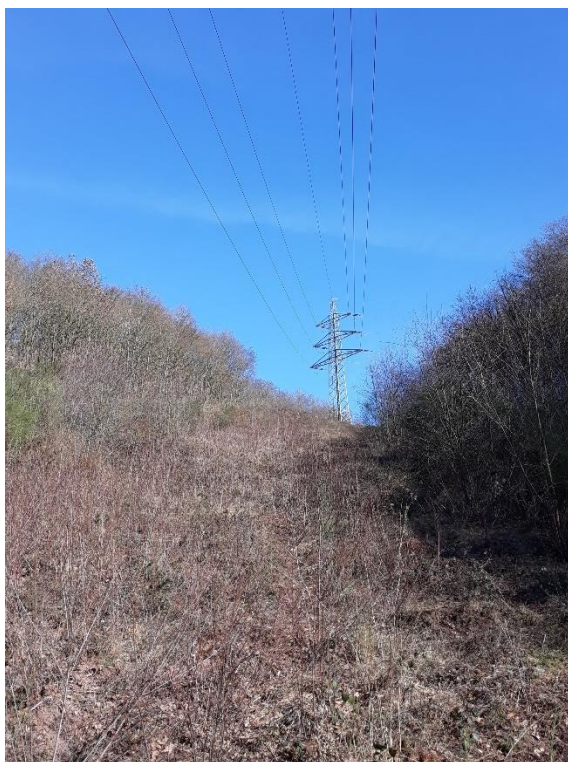
Abbildung 18: Blick vom Maststandort 10 zu Mast 11 durch die Leitungsschneise, Blickrichtung Osten.
