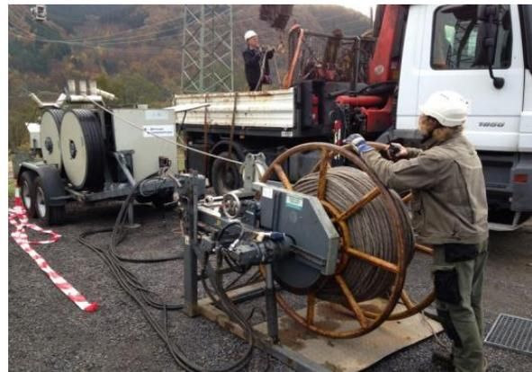
Abbildung 3: Seilbremse und -winde
