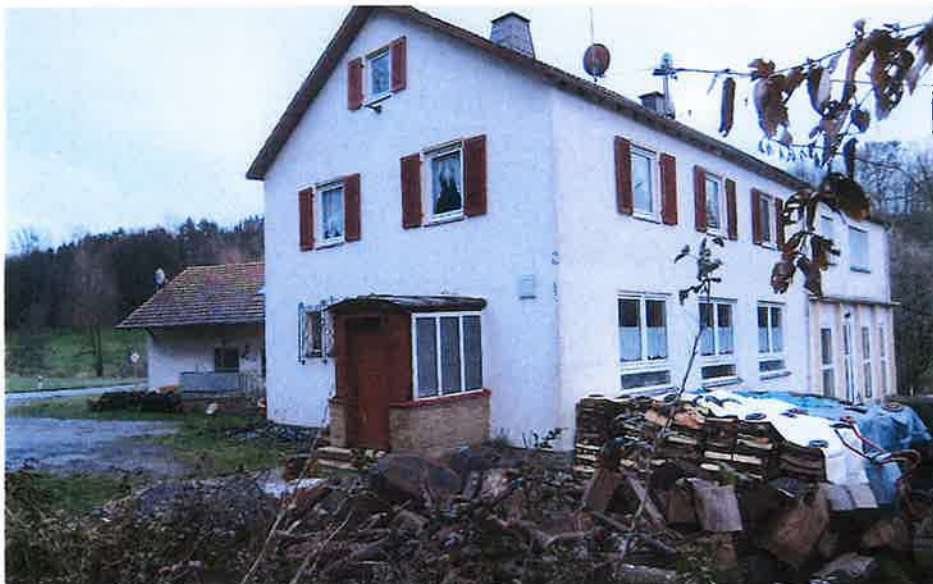
Bild 2: Blick aus nordwestlicher Richtung auf die Kirschbacher Mühle
