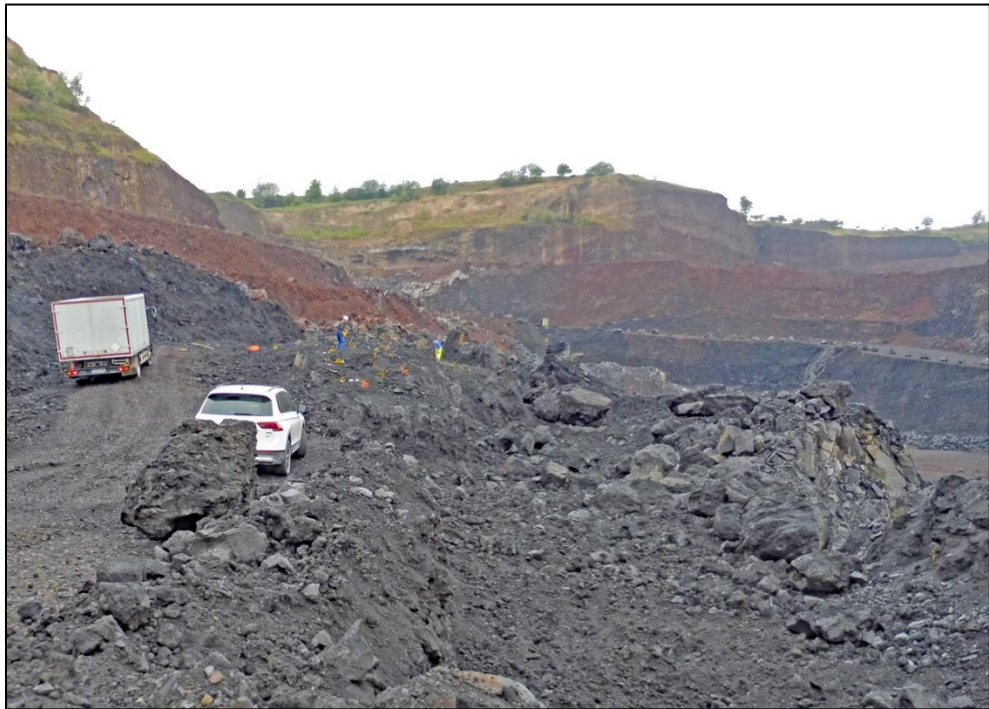
Abb. 2 Blick von Osten nach Westen in den Tagebau, etwa in Richtung der Erweiterungsfläche In der Bildmitte die Sprengstelle vom 13.07.21
