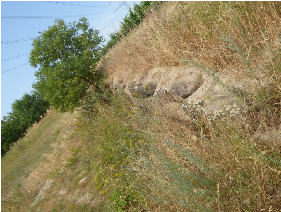
Abb. 10: Trockenmauer im Bereich des Arbeitsstreifens (L.A.U.B. 26.06.2023)
