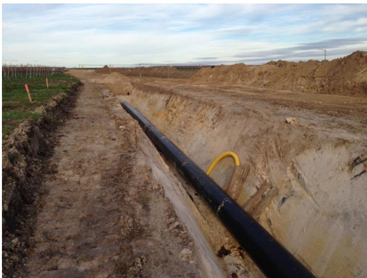
Abbildung 17: Abgesenkter Rohrstrang
