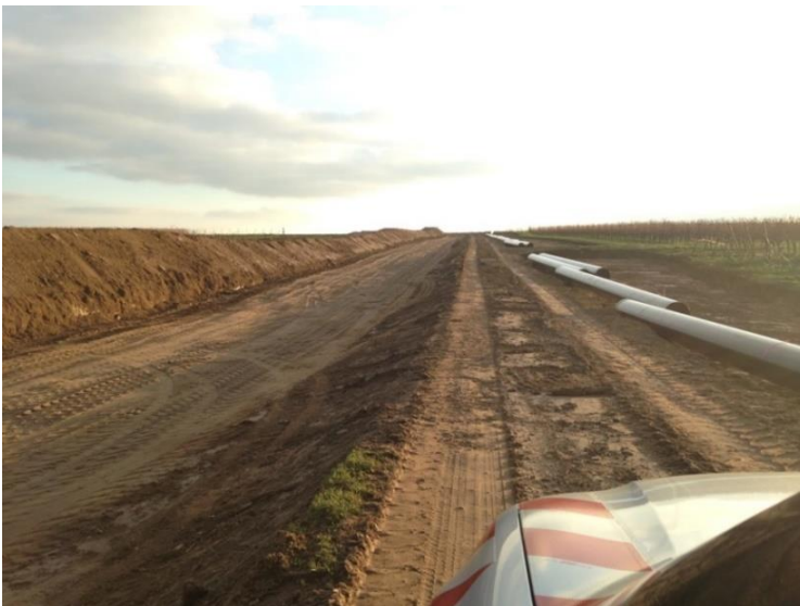
Abbildung 13: ausgefahrene Rohre
