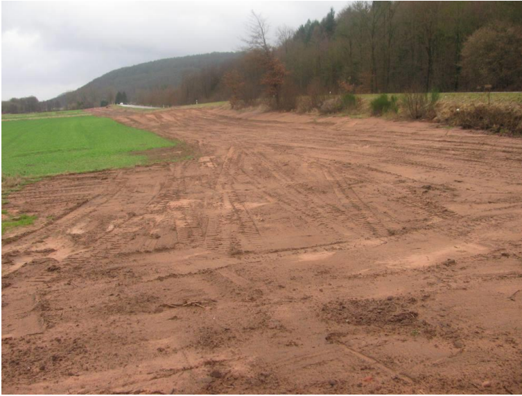
Abbildung 21: aufgetragener Oberboden
