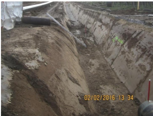
Abbildung 16: Rohrgrabenherstellung (Leitung DN 500)
