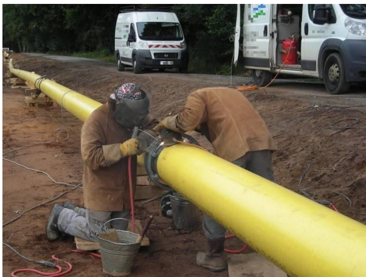
Abbildung 14: Verschweißen der Rohre
