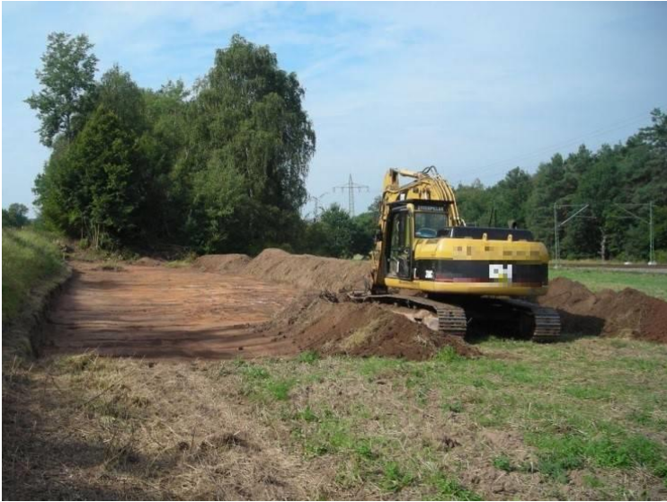
Abbildung 12: Oberbodenabtrag
