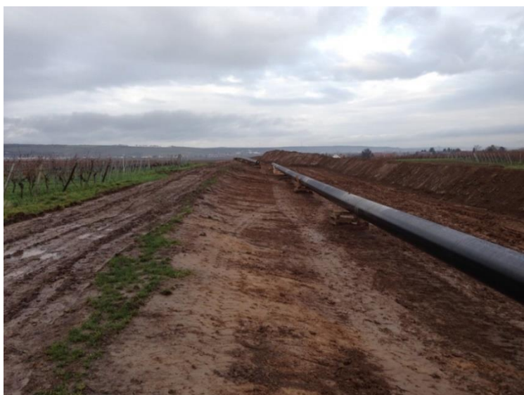
Abbildung 15: Vorgebauter Rohrstrang
