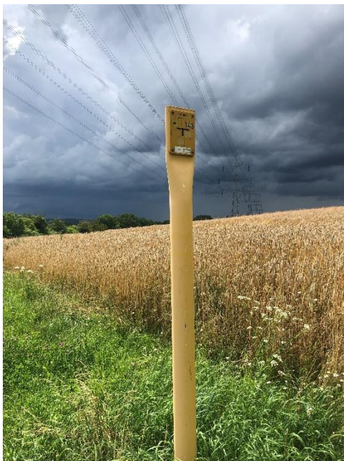
Abbildung 22: Schilderpfahl und Normschild nach DIN 4065
