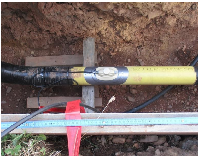
Abbildung 19: Aufgebrachter Messkontakt
