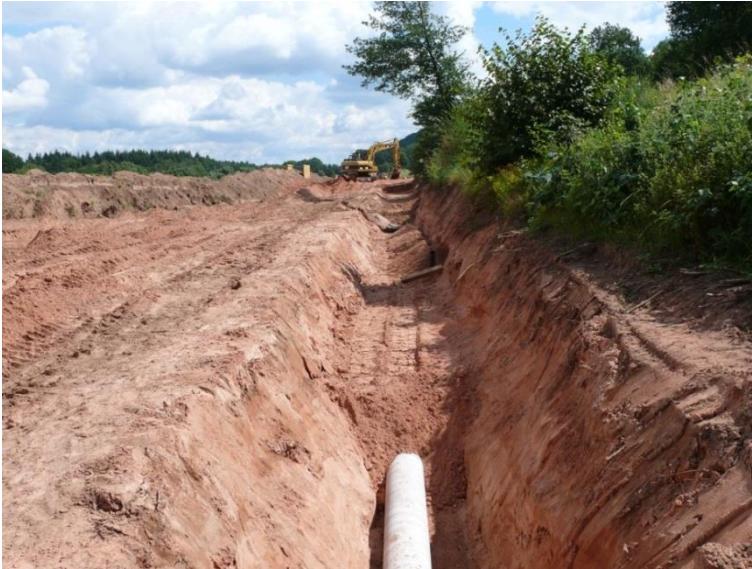
Abbildung 20: Rohrgrabenverfüllung
