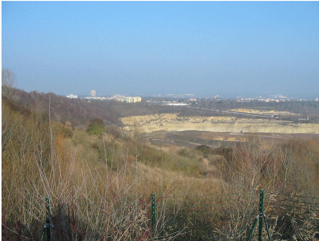
Steinbruch von Aussichtspunkt K 13 Richtung westlichen Deponiebereich
