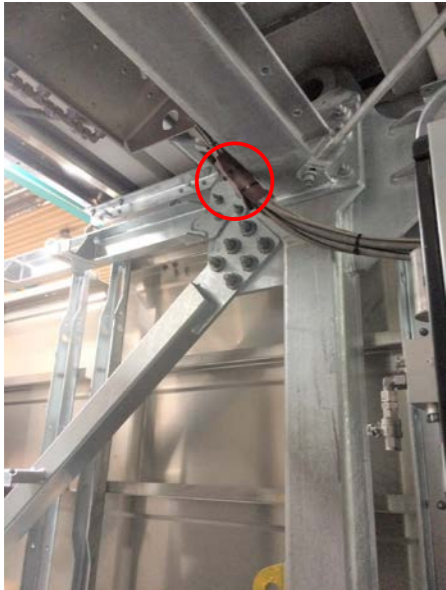
Bild 6: Scheuerschutz bauseits ("Speckmatte")
