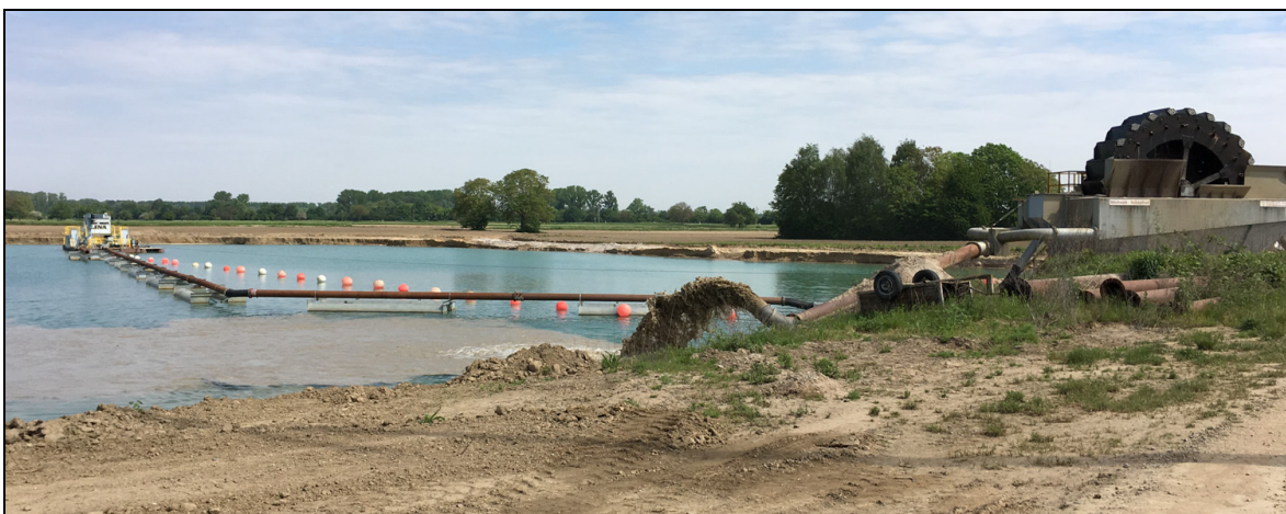
Abb. 17: Schwimmende Rohrleitung mit Schöpfrad (Quelle: Pfadt GmbH)
