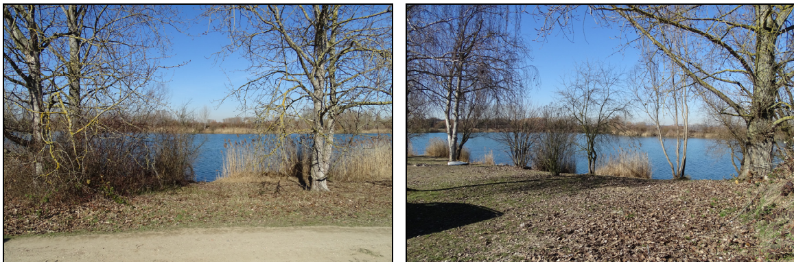
Abb. 84: In Anspruch genommene Uferbereiche des Taläckersees (Südufer) für die geplanten Dammschüttungen (linkes Bild: Anschlussstelle westliche Dammschüttung; rechtes Bild: Anschlussstelle östliche Dammschüttung)
