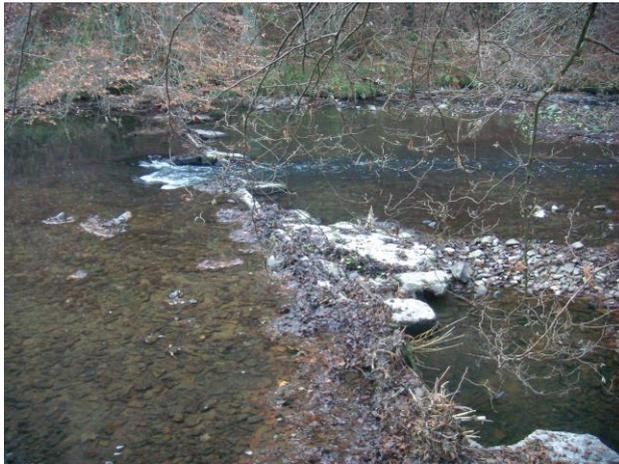
Abbildung 4: Marode Schwelle der alten Wehranlage Schneidmühle
