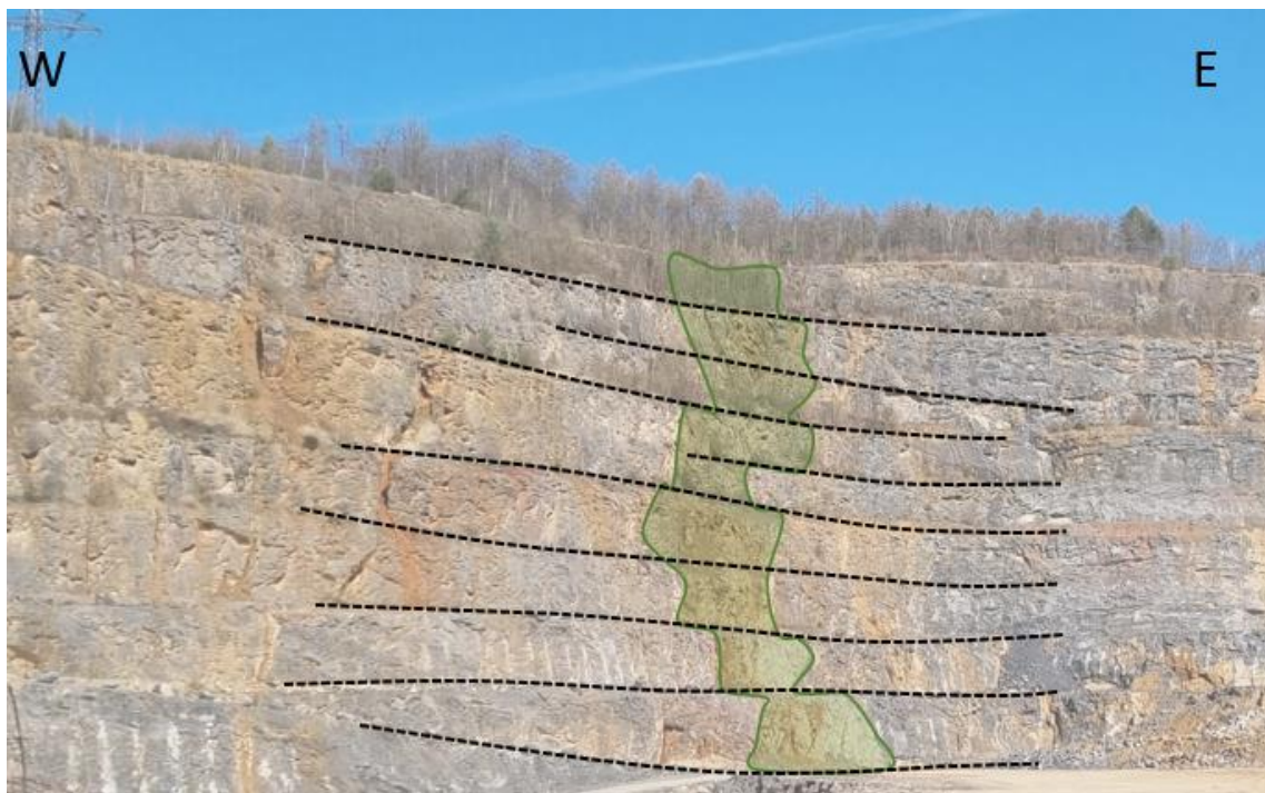
Abbildung 3: Postvariszische NNW-SSE verlaufende Störungszone (grün), hier: aufgeschlossen im nördlichen Bereich des Steinbruchs. Böschungskanten sind schwarz gekennzeichnet.
