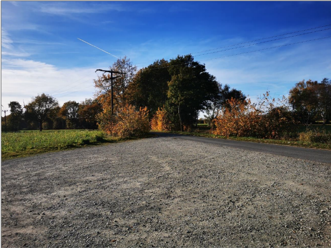
Abbildung 20: Geschotterter Stichweg der WEA4alt (Blickrichtung Westen).
