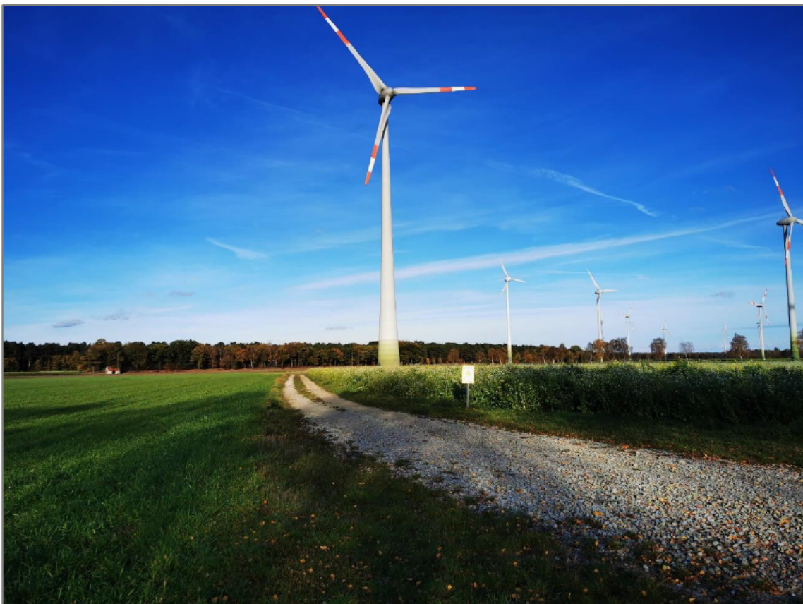
Abbildung 19: Stichweg zur WEA1alt (Blickrichtung Nordosten).
