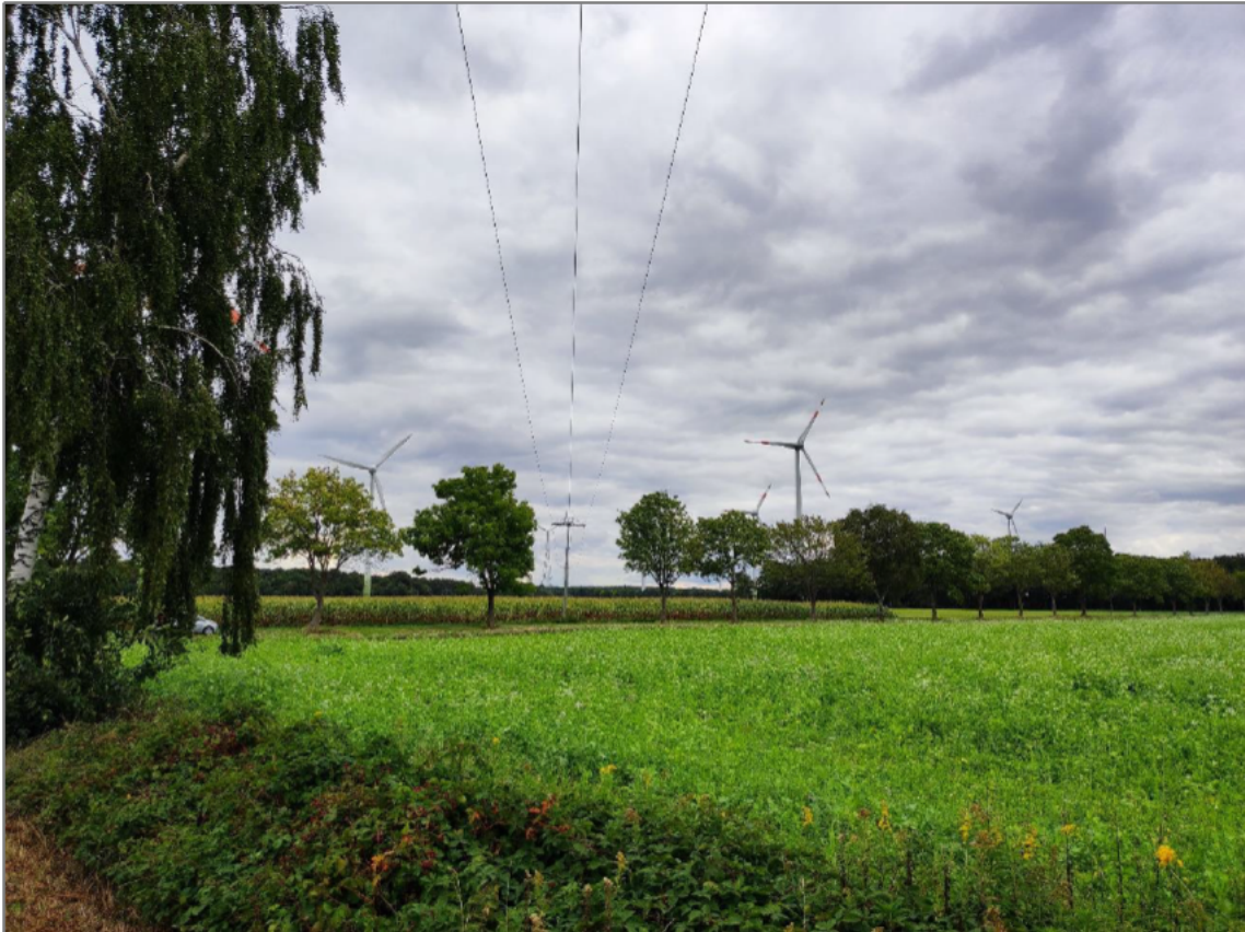
Abbildung 24: Eine der 10kV-Stromleitungen im Untersuchungsgebiet (Blickrichtung Nordosten).
