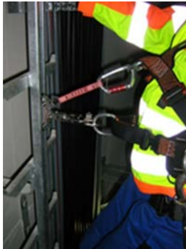
Abb. 6: Position mitlaufendes Auffanggerät
