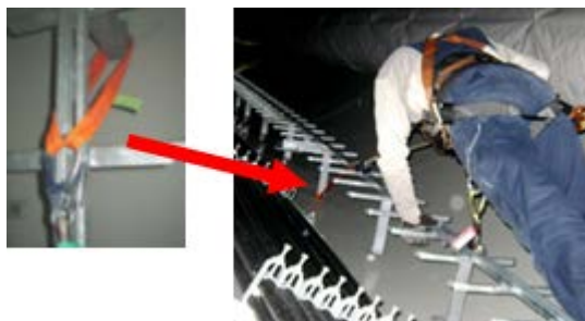
Abb. 40: Befestigung der langen Bandschlinge
