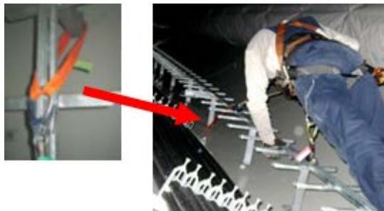
Abb. 10: Befestigung der langen Bandschlinge
