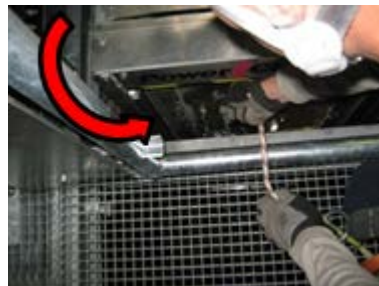
Abb. 29: Rettungsseil durch die Durchfahrtsöffnung der Aufstieghilfe ablassen
