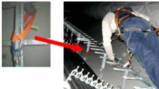
Abb. 26: Befestigung der langen Bandschlinge
