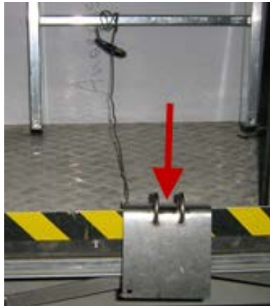
Abb. 20: Kantenschutzblech aufgelegt und gesichert
