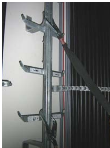
Abb. 5: Bandfalldämpfer in der Sicherheitssteigleiter
