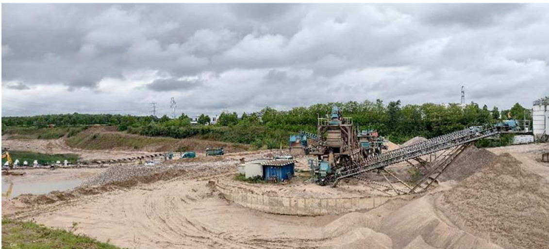
Blick von Norden auf das vorhandene Kieswerk
