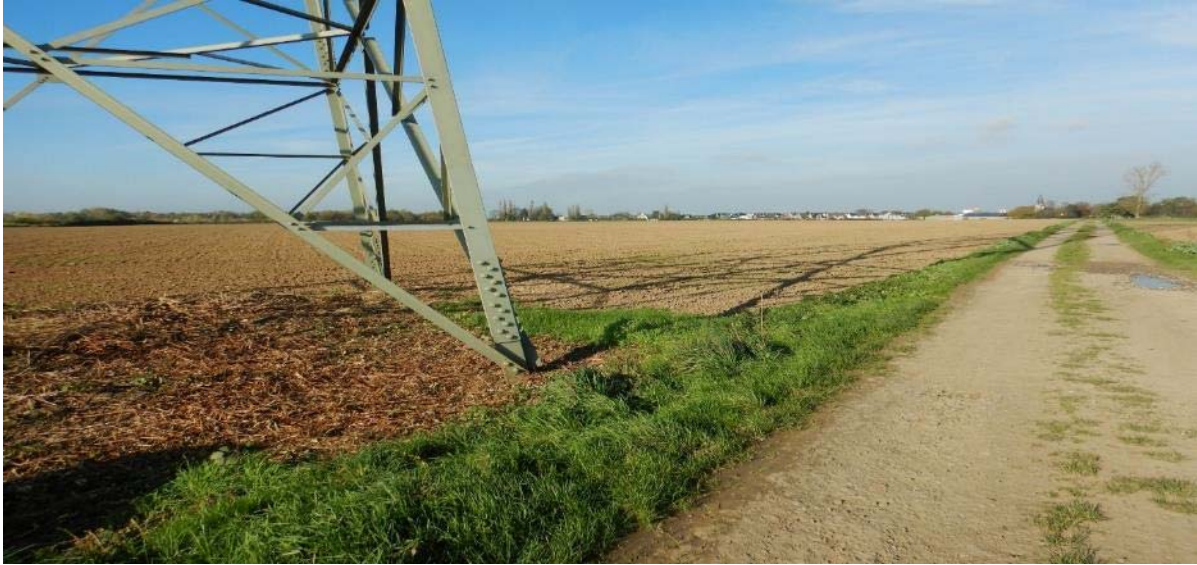
Blick entlang des Weges an der Ostgrenze des Vorhabens nach Nordosten, im Hintergrund Uckendorf
