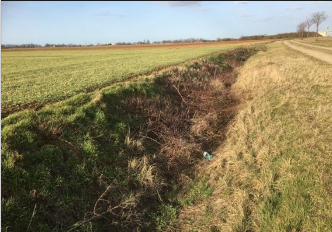
Abb. 8: Der Graben verläuft entlang des Ackers an der L 238 und wird zum Teil für die Zuwegung zur WEA 1 beansprucht.
