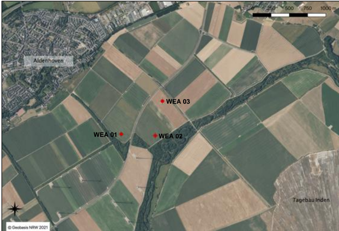
Abb. 2: Luftbild der geplanten Anlagenstandorte (rote Punkte) zwischen Aldenhoven und dem Tagebau.
