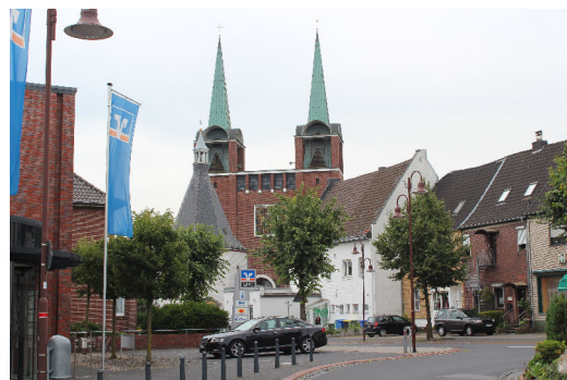
B: Blick aus südwestlicher Richtung
