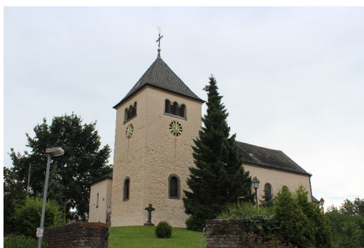
A: Blick aus nordöstlicher Richtung
